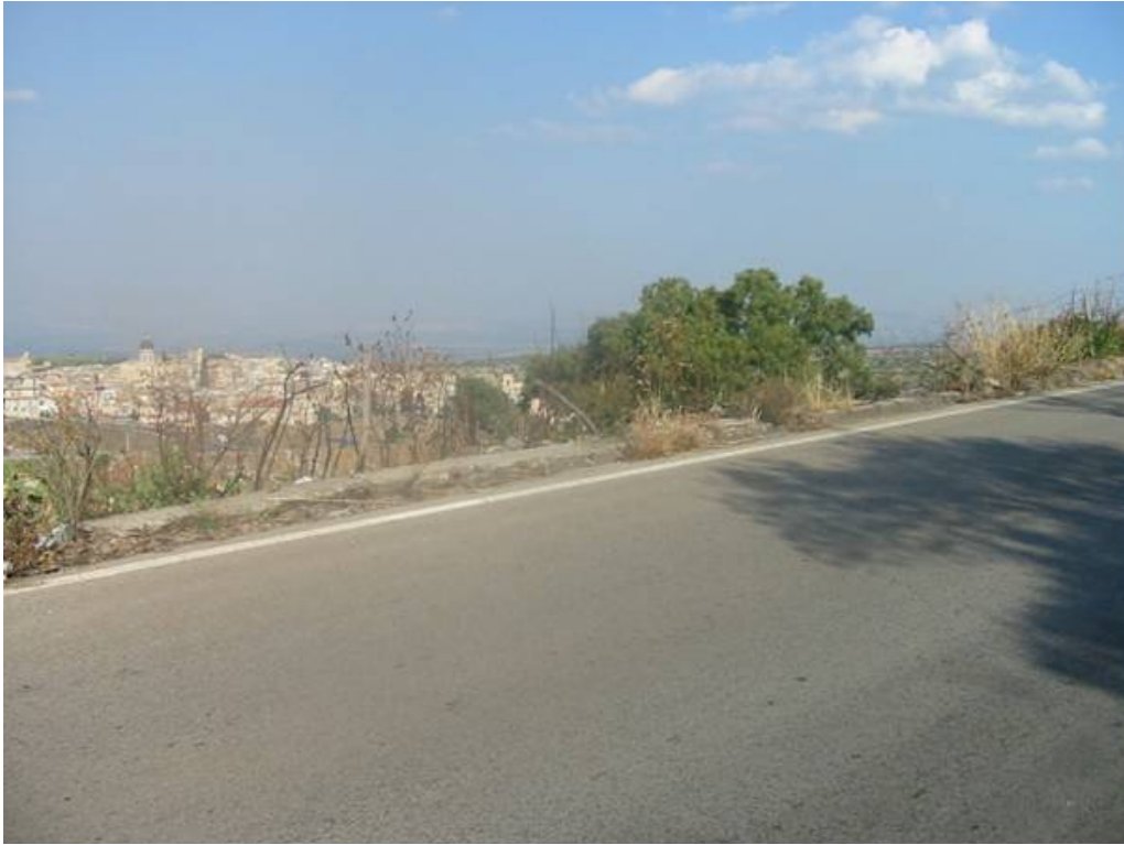
Figura 47 Rilevato alto non protetto: problema di grado elevato.
