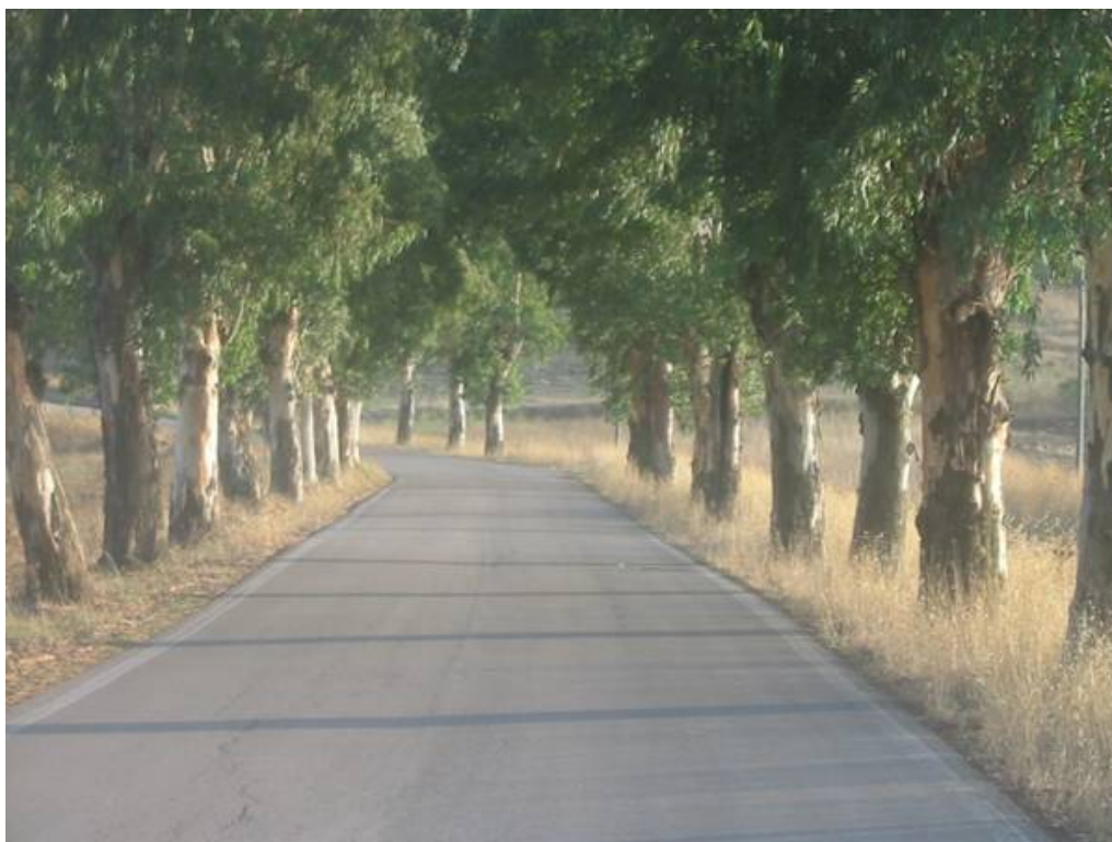
Figura 62 Alberi di grande diametro vicini alla carreggiata: problema di grado elevato.
