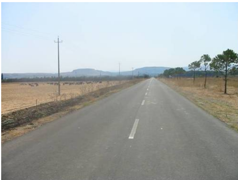
Figura 36 Striscia centrale lievemente degradata: problema di grado basso.
