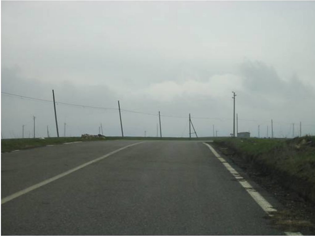
Figura 5 Curva con difficoltà di percezione non delineata: problema di grado elevato.
