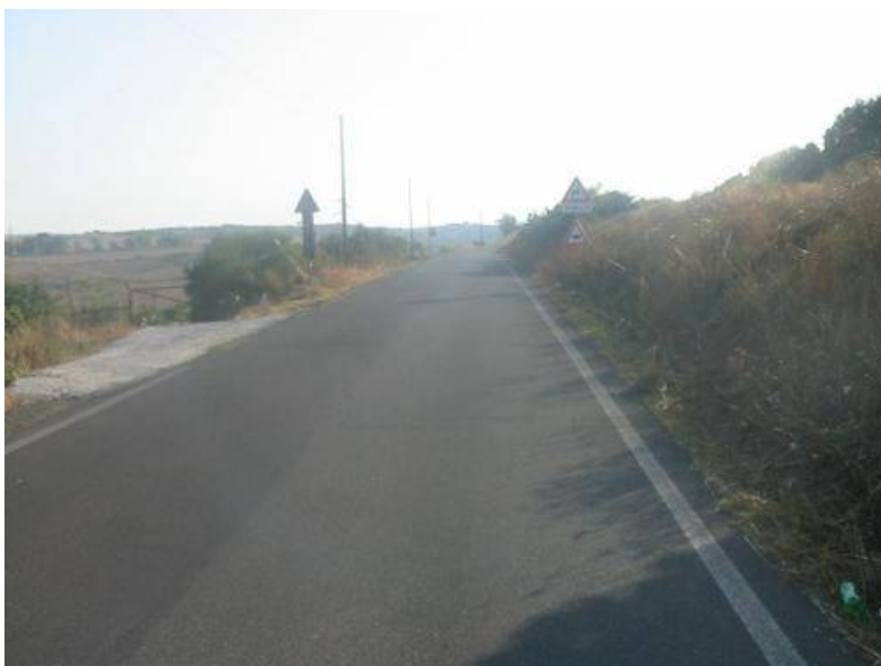
Figura 35 Striscia centrale assente: problema di grado alto.
