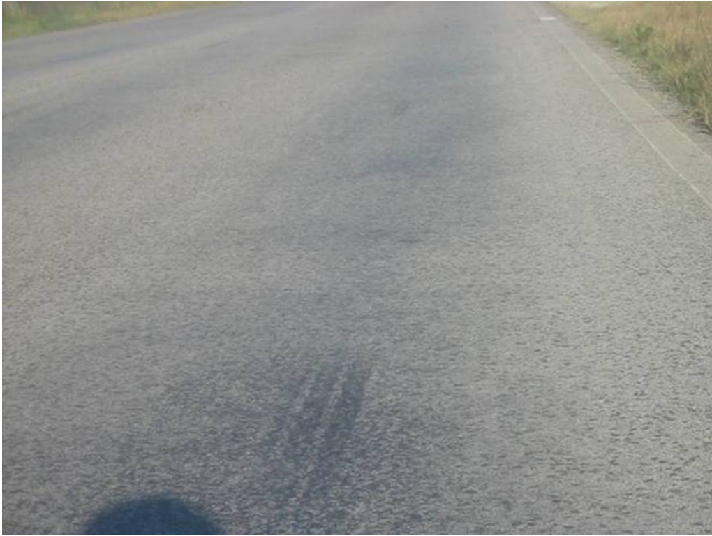
Figura 37 Aggregati levigati.
