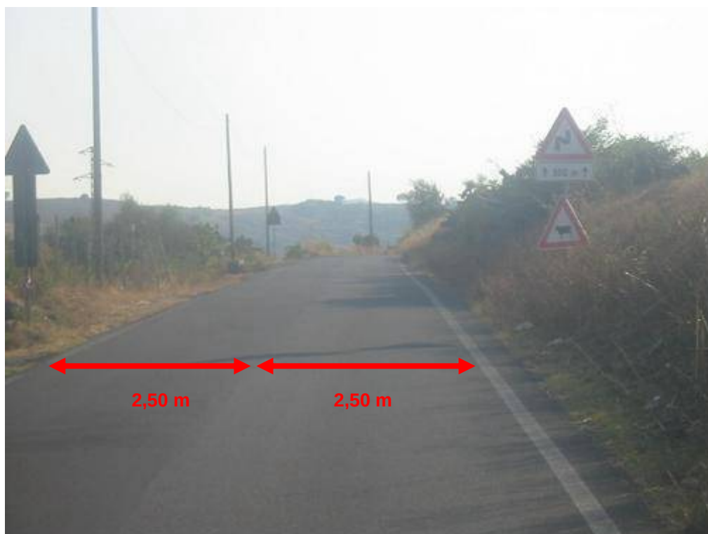
Figura 23 Larghezza della corsia inferiore a 2,75m: problema di grado elevato.
