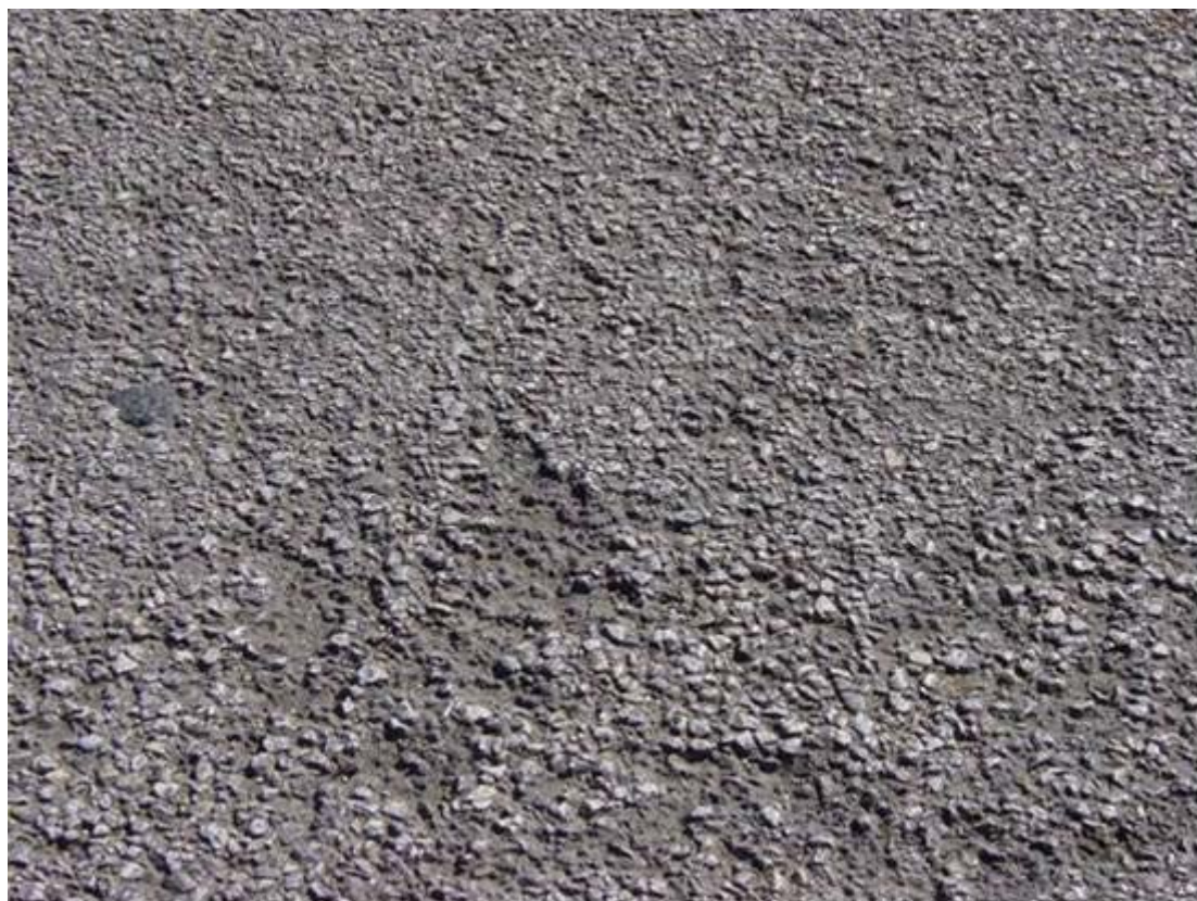
Figura A12 - Sgranamento degli aggregati superficiali.
