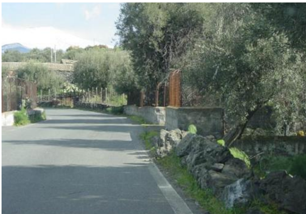
Figura 20 Accessi privi dei delineatori di accesso.
