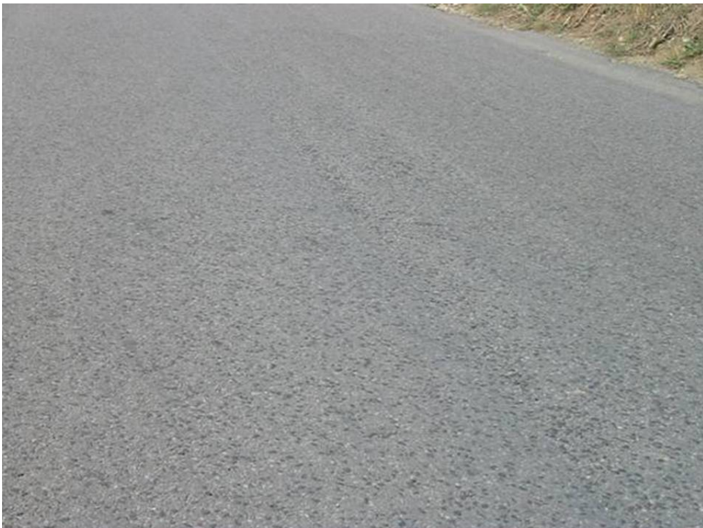
Figura 38 Aggregati levigati.
