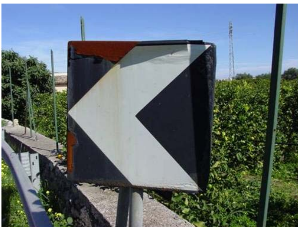
Figura A25 - Delineatore degradato.
