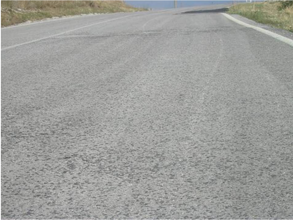
Figura 39 Aggregati levigati.
