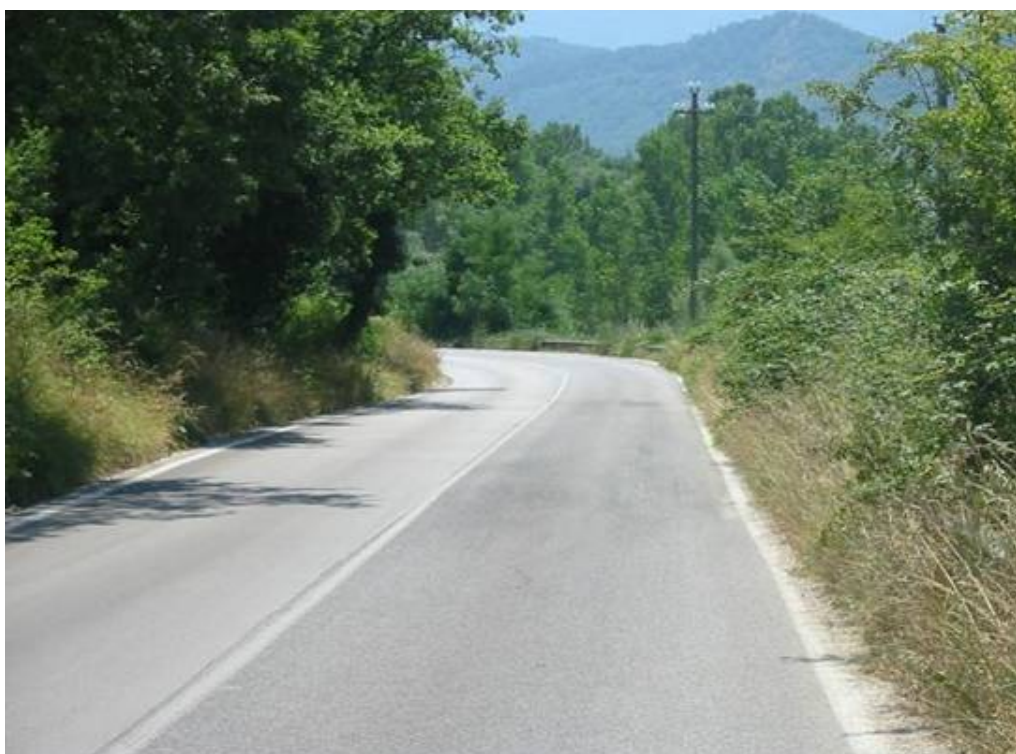
Figura 30 Mancanza di visibilità in curva: problema di grado elevato.
