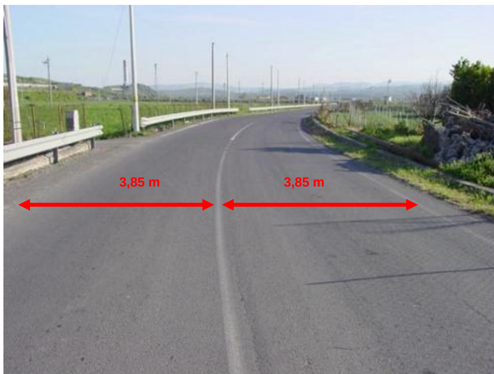
Figura 25 Elevata larghezza delle corsie: problema di grado basso.
