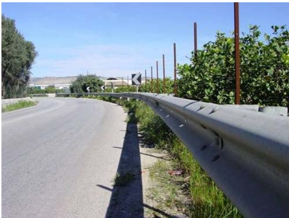
Figura A24 - Mancanza di continuità e nella delineazione.
