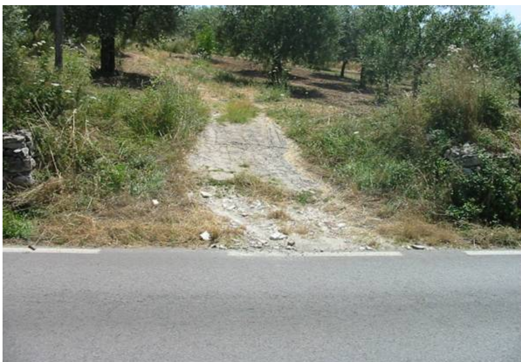
Figura 21 Accesso non pavimentato e privo di segnaletica: problema di grado basso.
