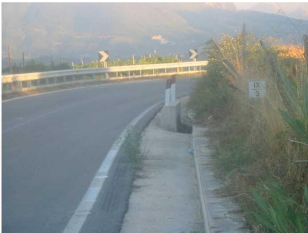
Figura 68 Ostacolo rigido: problema di grado elevato.
