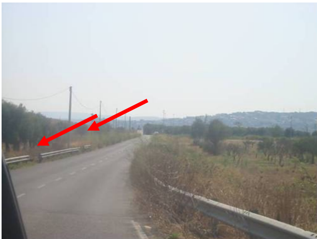
Figura 22 Elevata frequenza degli accessi: problema di grado elevato.
