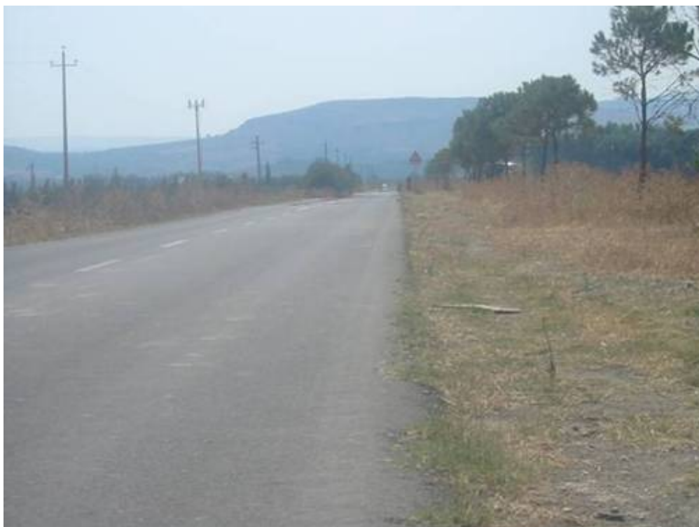
Figura 11 Assenza di delineatori sul margine: problema di grado elevato.
