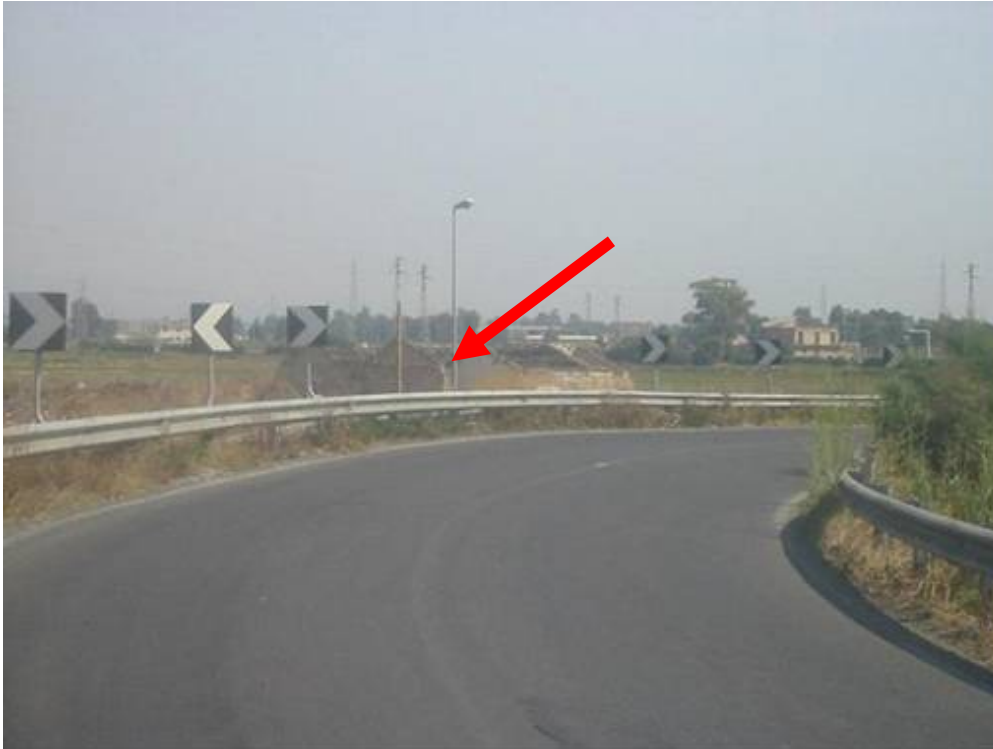
Figura 9 Discontinuità localizzata dei delineatori: problema di grado basso.
