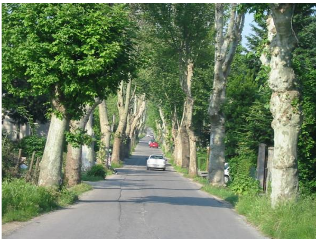
Figura 63 Alberi di grande diametro vicini alla carreggiata: problema di grado elevato.
