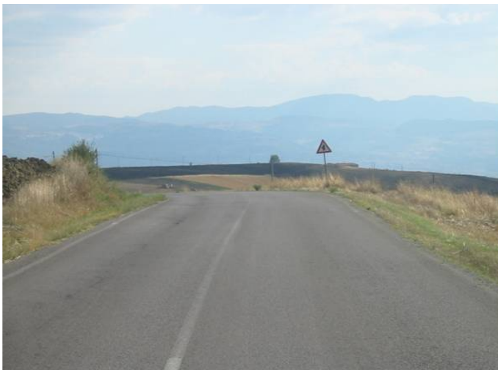
Figura 31 Mancanza di visibilità in curva: problema di grado basso.
