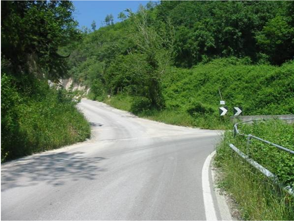
Figura 18 Accesso in curva di raggio ridotto: problema di grado elevato.
