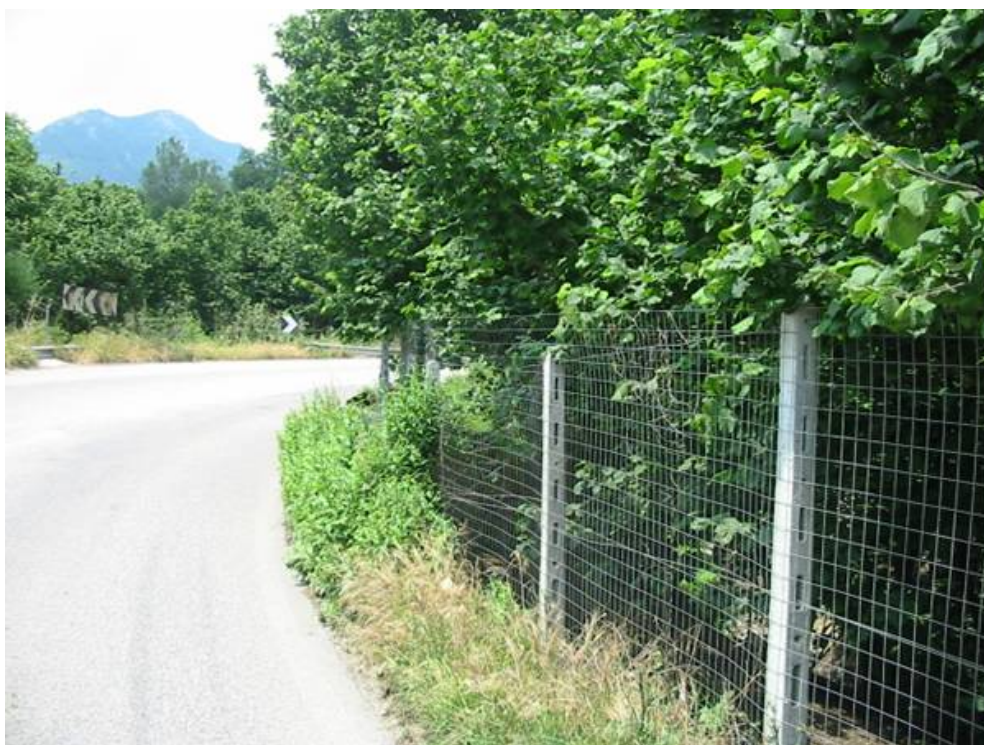
Figura 28 Mancanza di visibilità in curva: problema di grado elevato.
