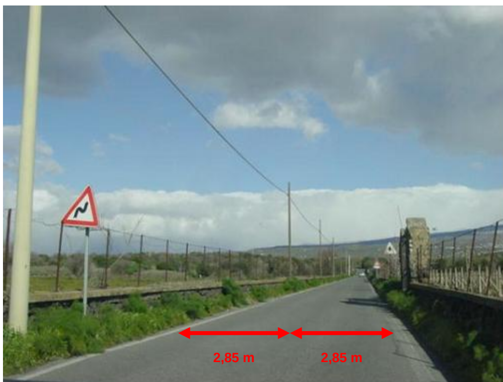
Figura 24 Larghezza compresa tra 2,75 m e 3,25 m problema di grado basso.
