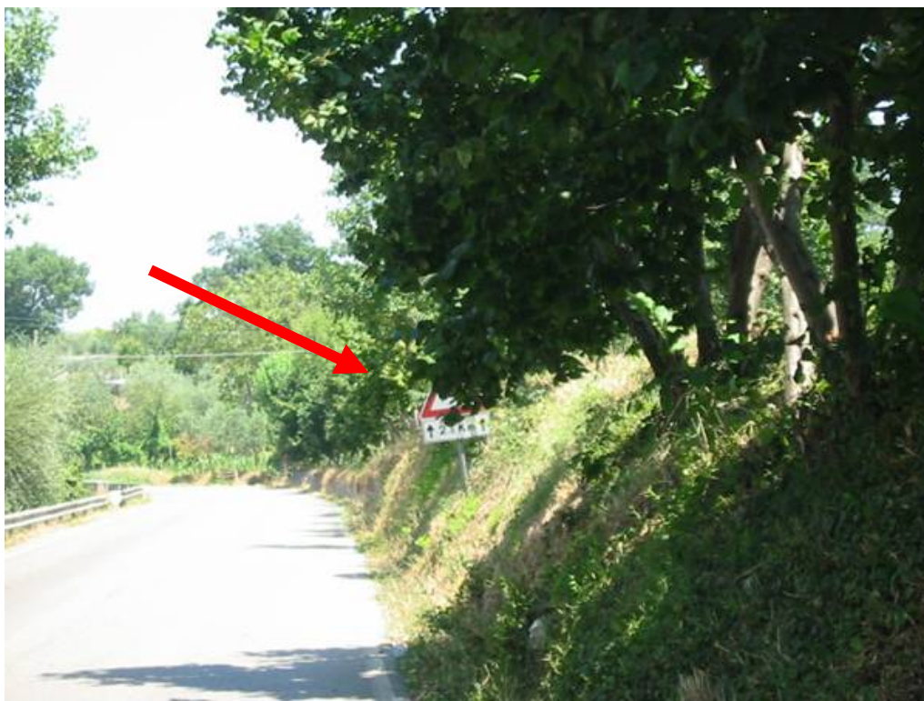
Figura 14 Segnale di pericolo non visibile: problema di grado elevato.
