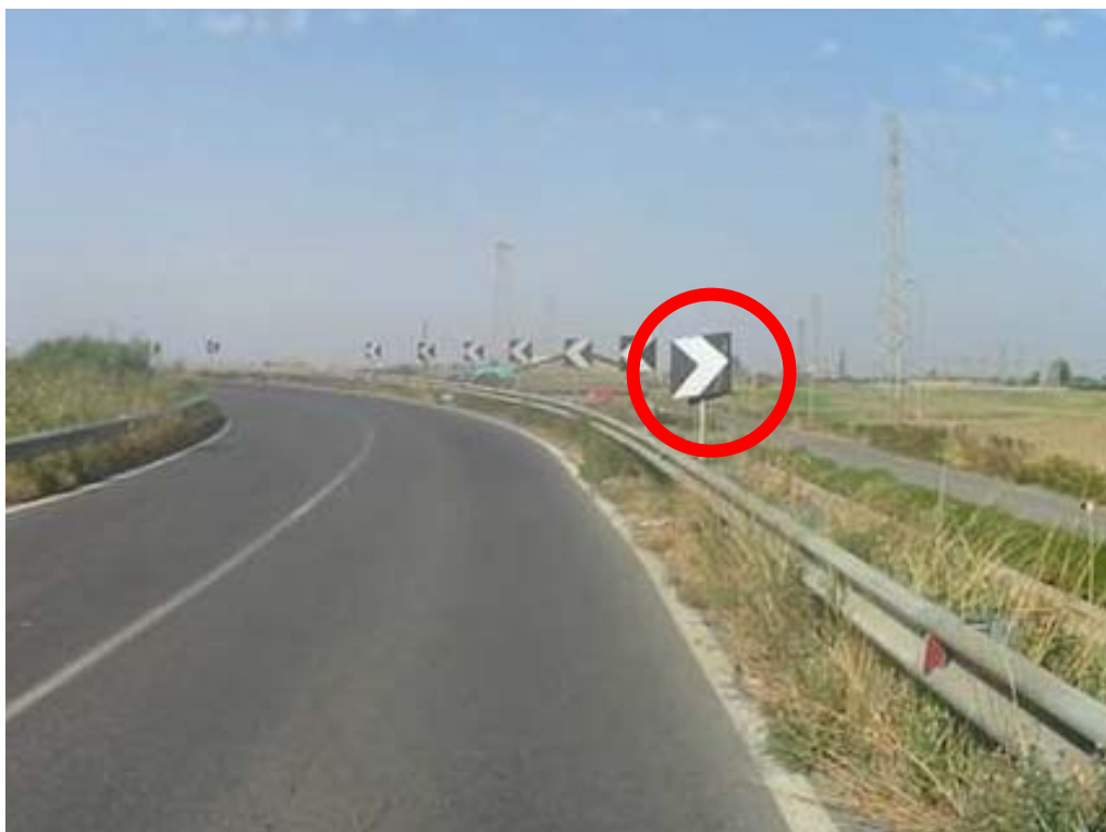
Figura 7 Delineatore nel senso opposto alla curva: problema di grado elevato.
