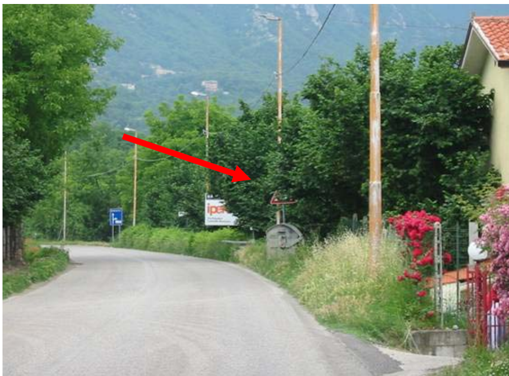
Figura 15 Segnale di preavviso intersezione con diritto di precedenza coperto dalla vegetazione: problema di grado lieve.
