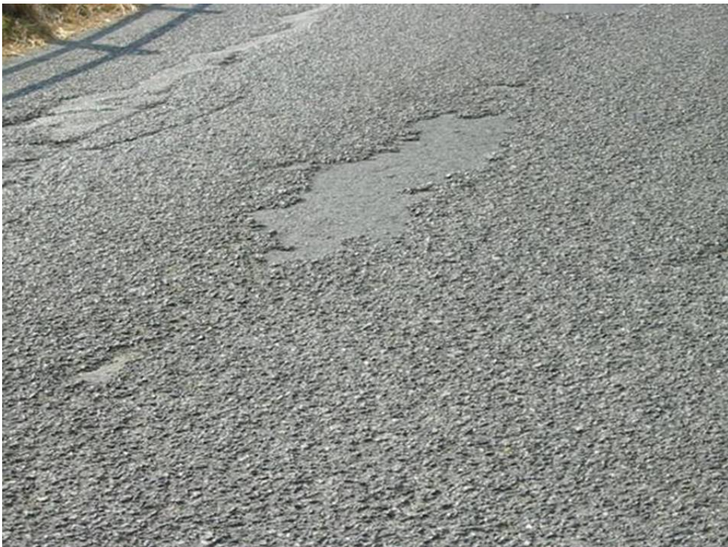
Figura 42 Sgranamento degli inerti.
